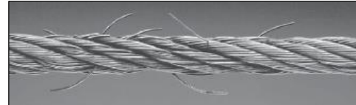
Câble Avec Fils Cassés
